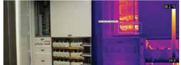
Obwohl diese Ausgangsklemmen wirklich heiß sind, liegen die gemessenen Temperaturen im Normbereich für diese Art der Belastung.
