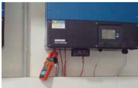
Diese Wechselrichter wandeln den Gleichstrom der Solarmodule in Wechselstrom um.
