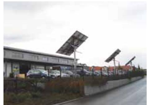
Diese auf Masten montierten Solarmodule lassen sich von hinten untersuchen, um Reflexionen zu minimieren.
